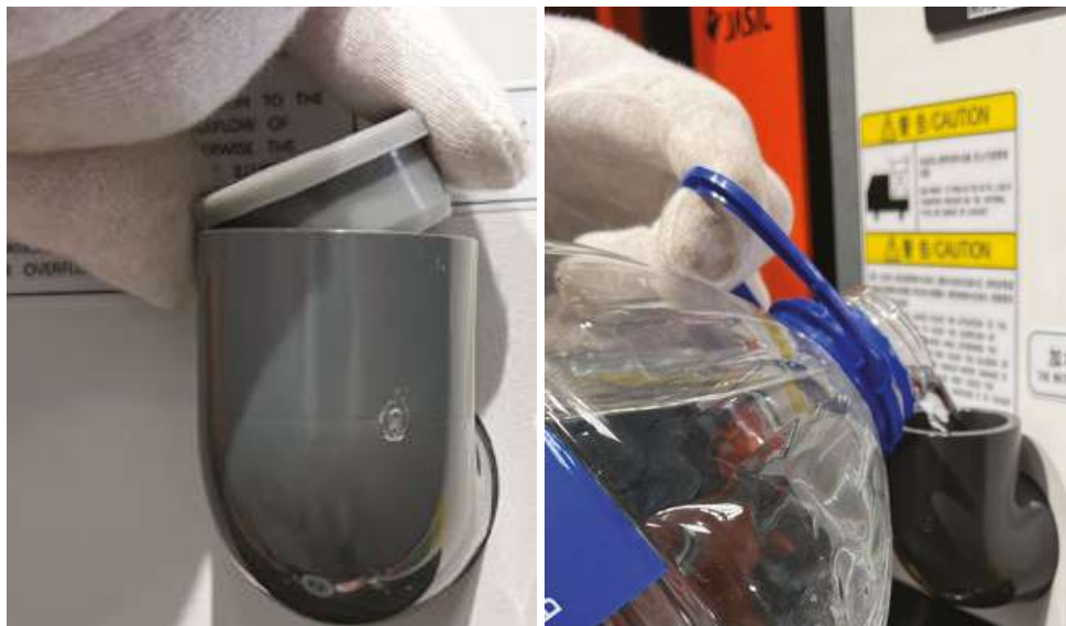
Фото 9.0.3. Заливание охлаждающей жидкости.
